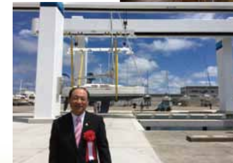
ヨット用大型クレーン新設
